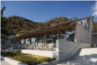
ベネッセハウス テラスレストラン 写真：渡邊修
